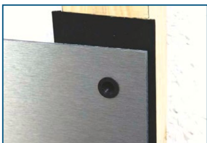
Abb. 11 - Gleitpunkt: Fa-Ze-Di-Ring in Plattenbohrung
