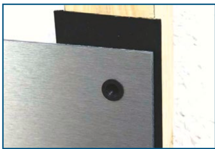
Abb. 11 - Gleitpunkt: Fa-Ze-Di-Ring in Plattenbohrung
