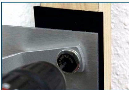
Abb. 9 - Einsatz Bügelbohrvorrichtung, Vorbohren der Holz-UK
